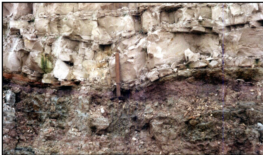
Рис. 9. Характер залегания известняков и глин каменноугольной системы в районе Москва-Сити: сверху – общий вид, внизу – деталь строения стенки котлована (фото А.И. Полетаева, 1999 г.).
